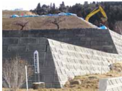
被災した町立船越小学校の復旧工事の様子(現在は造成工事中)
