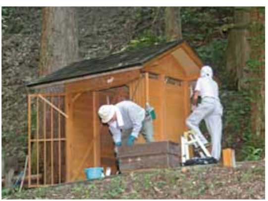
社の清掃や塗装の塗り直しなど、暑い中、作業が続きました。
