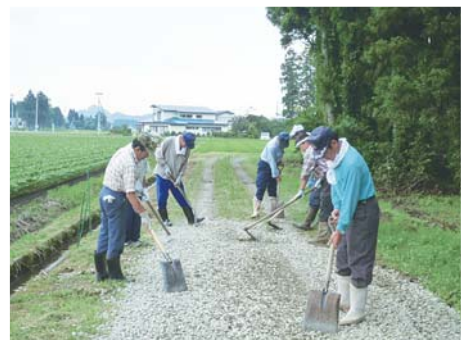
農道の敷き砂利作業
