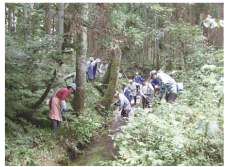
末端水路の整備
