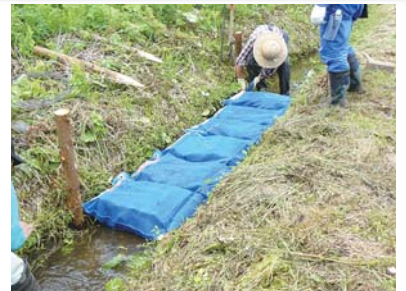
水質改善のための木炭を埋設
