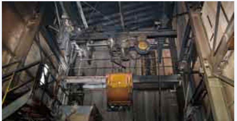
被災したバイオエネルギーセンター
