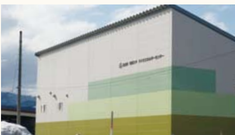
本格的稼働が待たれる木質バイオ発電施設
