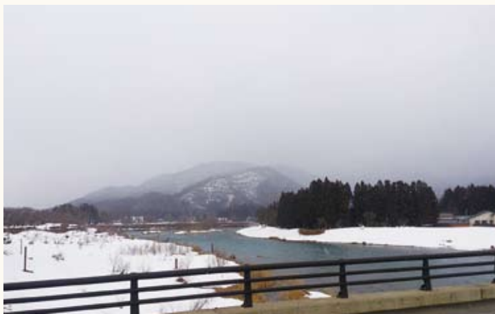
カヌーコースの再建に（広久内橋付近）
