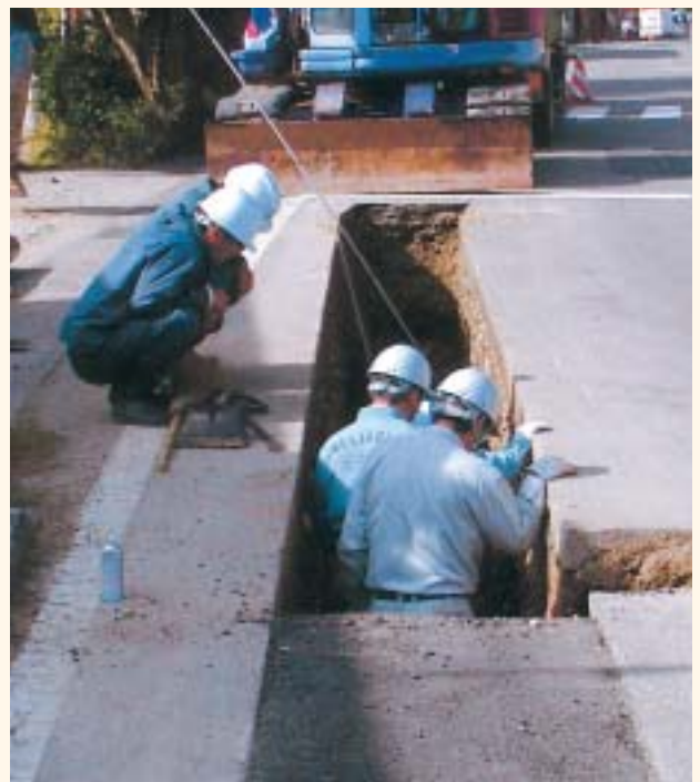
老朽管入れ替え工事
