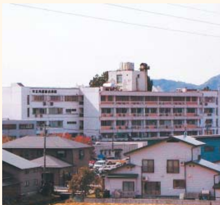
老朽化が目立つ角館総合病院
