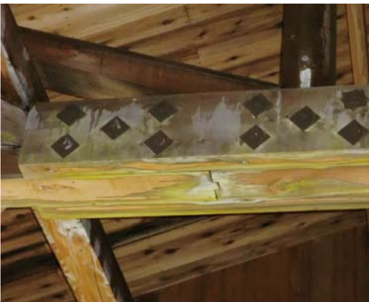
ボルト腐蝕による修繕工事が行われるアルパこまくさ天井部分
