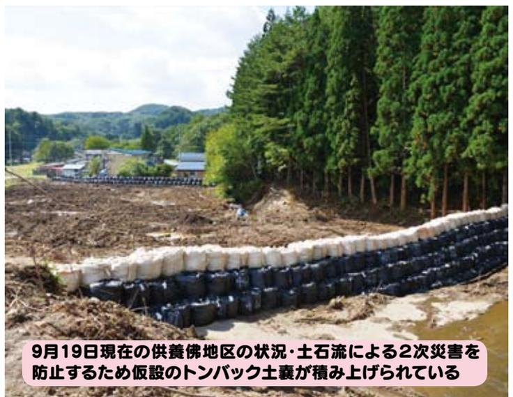
9月19日現在の供養佛地区の状況・土石流による2次災害を防止するため仮設のトンバック土嚢が積み上げられている
