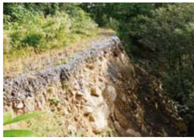
崩落著しい田沢スーパー林道
