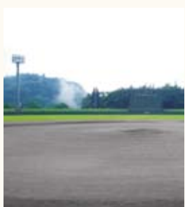
伊藤邦彦 記 公園内野球場の改修中
