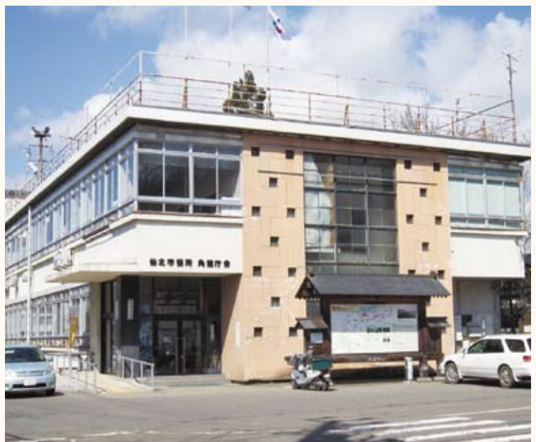
緊急避難待たなし！角館庁舎
