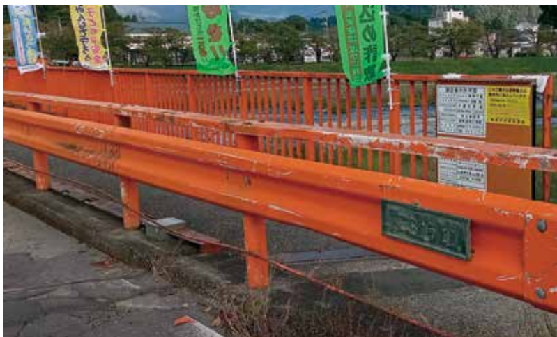
■大規模改修は令和9年頃になる見込みの横町橋
