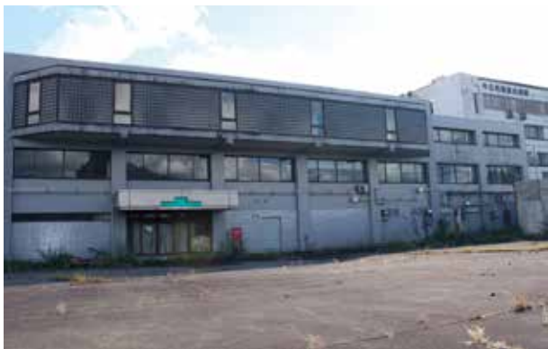
■本庁舎の移転が提案された旧角館総合病院管理棟（3階建て）
