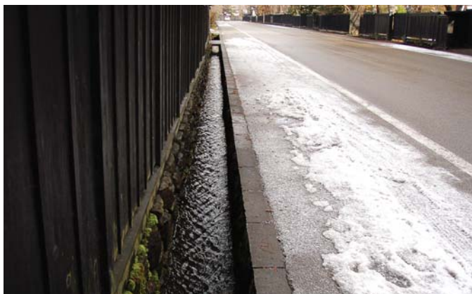
■安全対策が求められる伝建群水路
