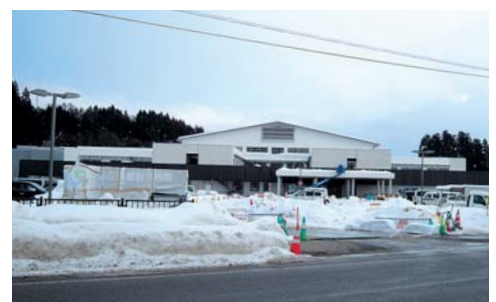
■完成間近の新角館総合病院
