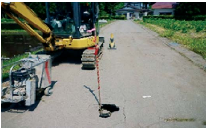
■道路中央部に突然穴の開いた市道
