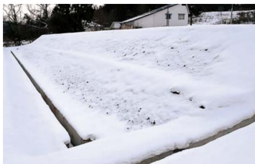
■湯野地区基盤整備法面
