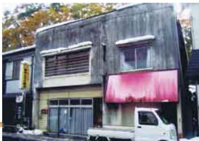
空き家対策条例による解体前
