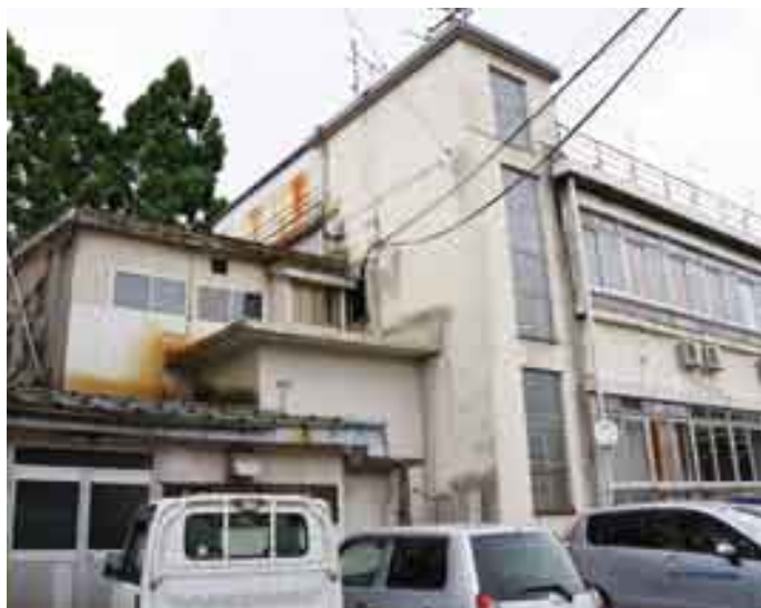
老朽化が著しい角館庁舎
