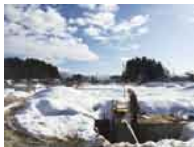
外構工事が進んでいる病院建設地
