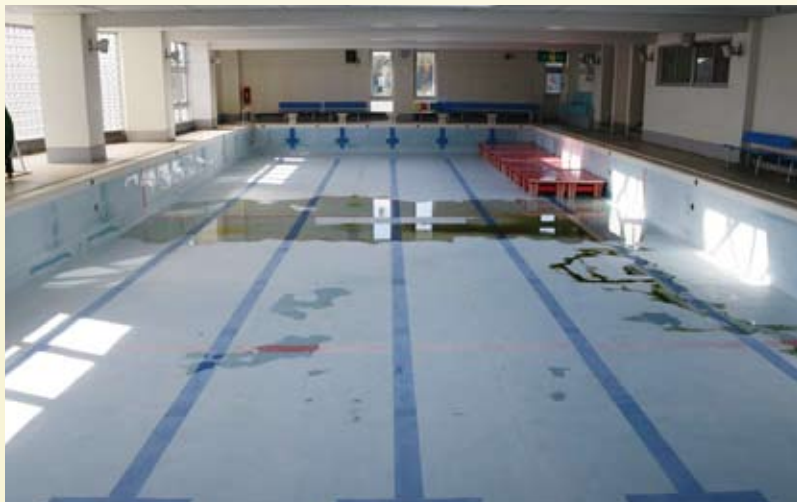
スポーツ、医療面で改修が待たれるクリオン温水プール
