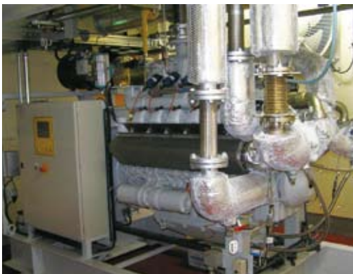
トラブル続きの木質バイオマス施設
