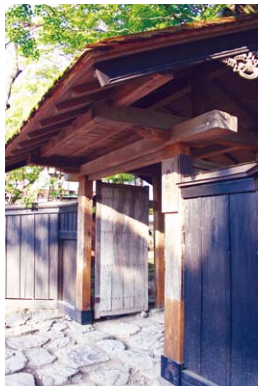
岩橋家の待たれる修理の屋根
