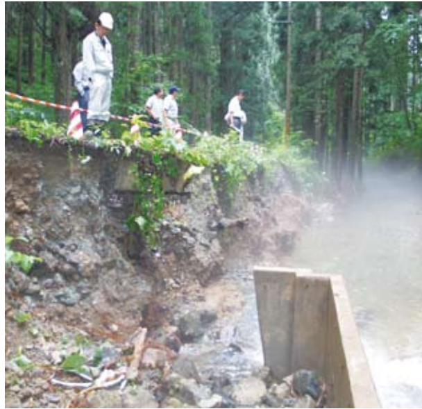
崩壊した道路路面
