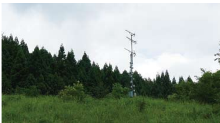
難視聴を解消する地上デジタルアンテナ
