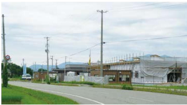
新築工事中の「のののはなデイサービスセンター」
