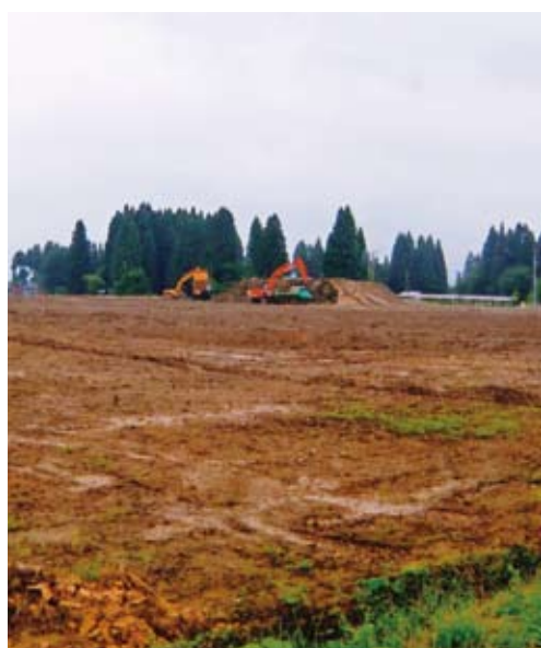
工事中の西明寺中学校野球場
