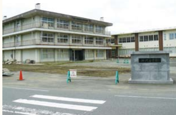
早期整備完了が求められる神代小学校解体工事現場
