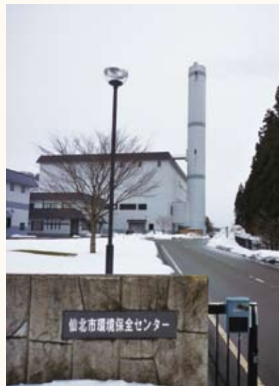
民間で運営している 環境保全センター
