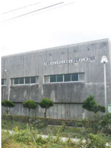
間もなく解体予定の旧し尿処理場
