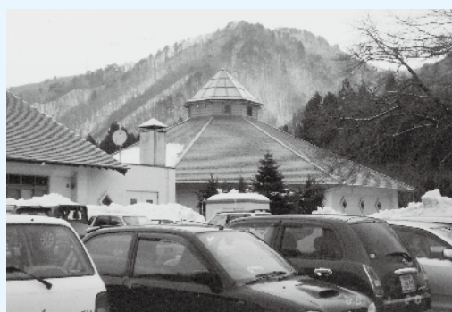
給湯ボイラー交換等2,500万円予算措置の花葉館
