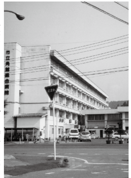
老朽化が進む市立角館総合病院
