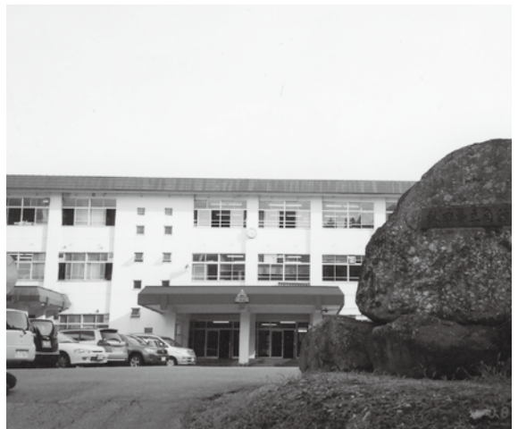
耐震度調査が必要となった老朽化の角館高校
