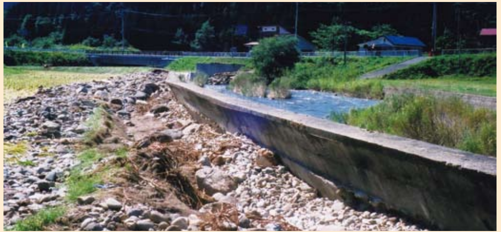
豪雨により堤防の土が水田に流入(上桧木内地区)
