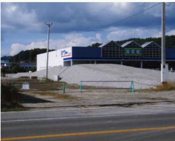
地盤を安定させるための盛られた土砂
