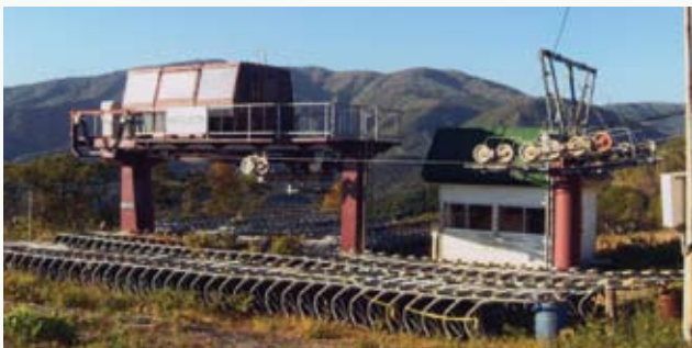
修理される水沢ロマンズリフト
