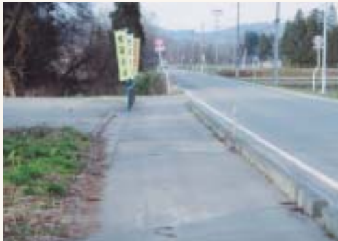
歩道工事が急がれる 広久内停車場
