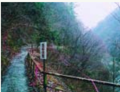
工事中の抱き返り遊歩道
