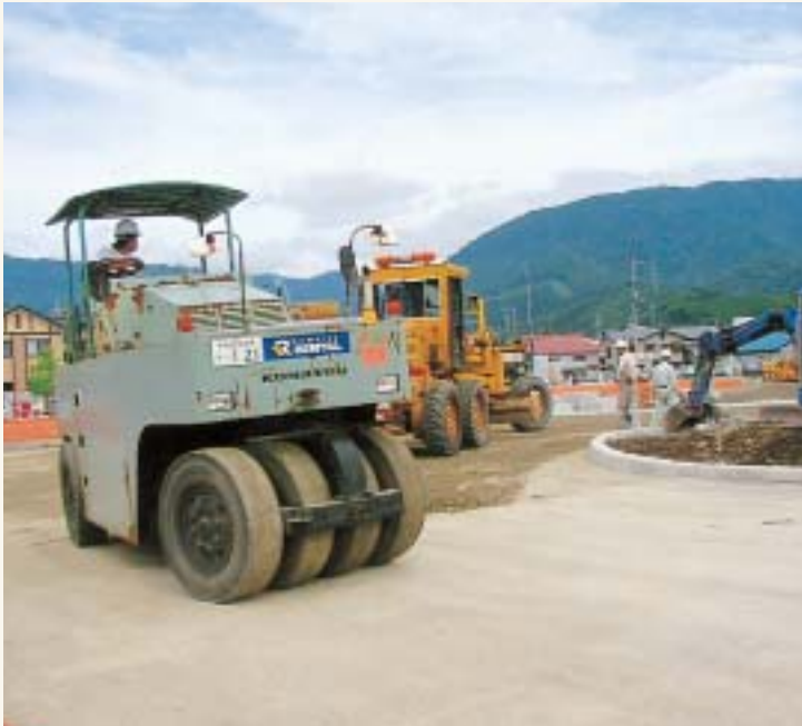
めっきり少なくなった工事現場
