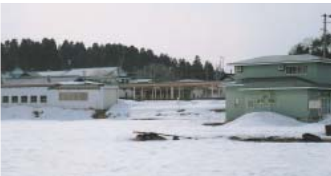
修正動議が出された角館駅東地区
