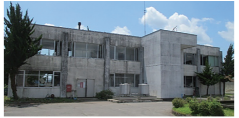
↑角館浄水場 (昭和51年建設)
