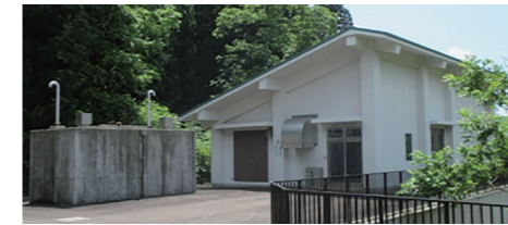
↑西明寺低区第2浄水場 (平成26年建設)
